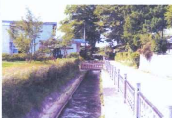
戸村堰の用水路と緑道の整備
