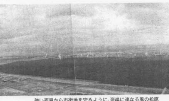
強い西風から市街地を守るように、海岸に連なる風の松原 =能代火力の築造中の煙突上から撮影=(同火力提供)
