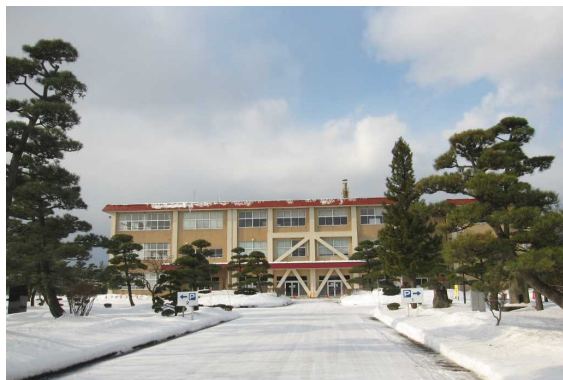
正面のデザインが少し変化しました。2008年昇降口棟の耐震化工事によるものです。
