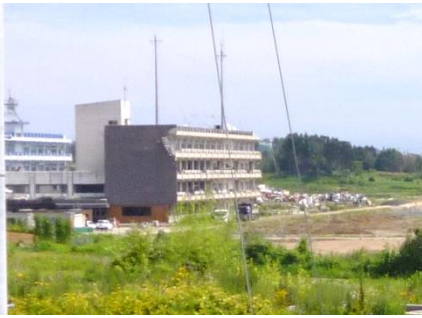
震災後の気仙沼向陽高校（H24.8.9） 現 東日本大震災遺構・伝承館
