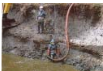
汚水抜き作業
