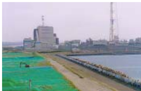
火力発電所と手前左側は石炭灰最終処分場
