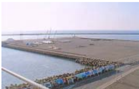
工業港の利活用に臨む 4 万トン岸壁
