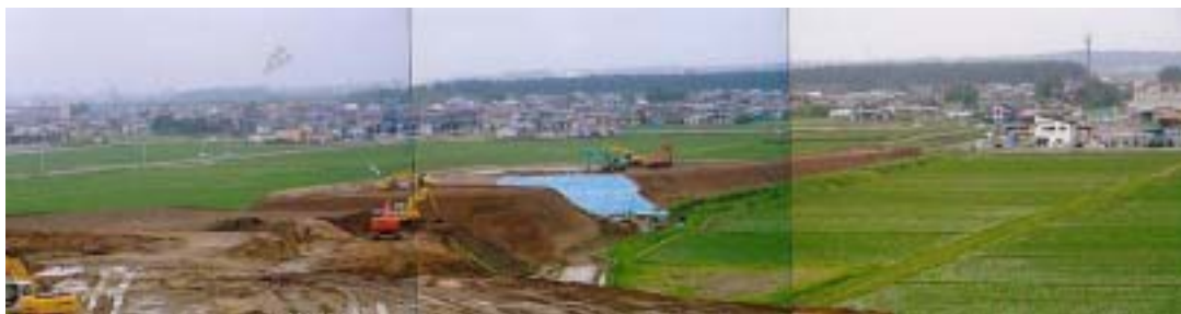
写真は、東インターチェンジ付近（05/6/12）
