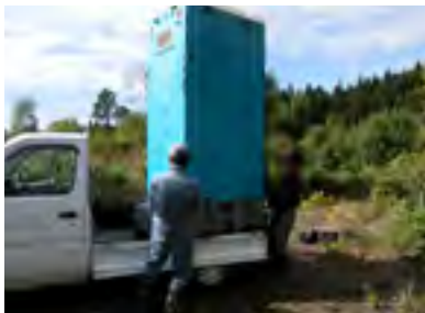
作業班が仮設トイレの運搬をしています。
